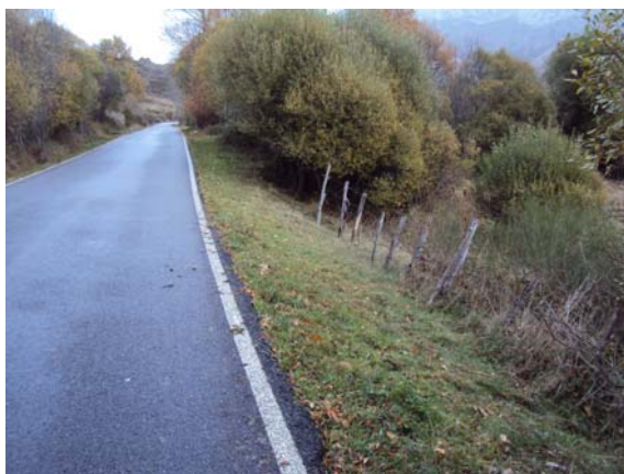
FOTO 1.- Conexión a tubería en Ctra. a Abelgas
