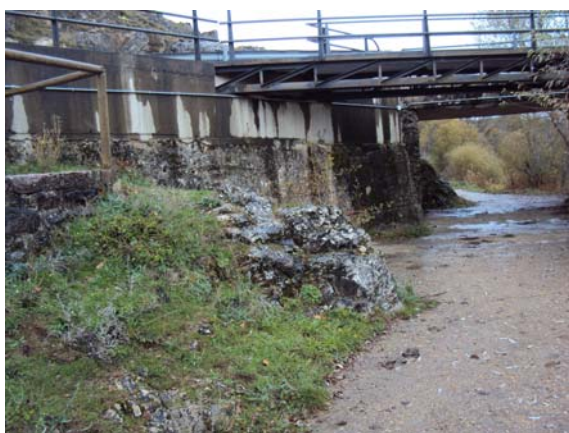
FOTO 3.- Traza zona de pasarela
