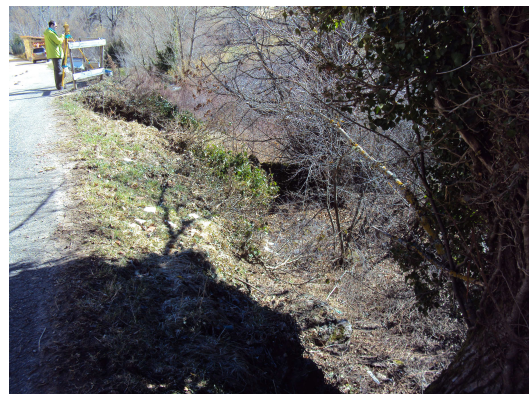
FOTO 4.- CALDAS. ZONA DE MURO
