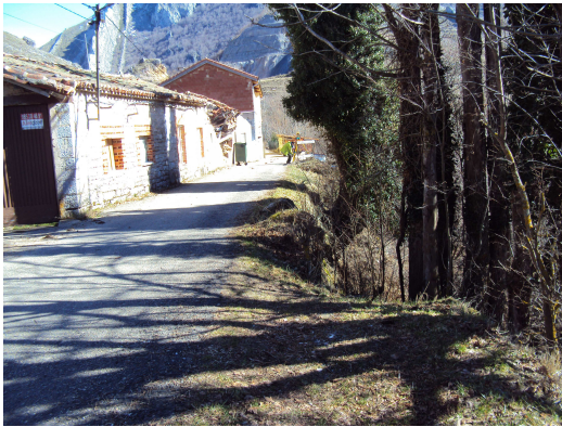
FOTO 3.- CALDAS. ZONA DE MURO
