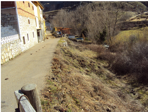
FOTO 5.- CALDAS. ZONA DE MURO
