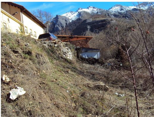
FOTO 7.- CALDAS. ZONA DE MURO
