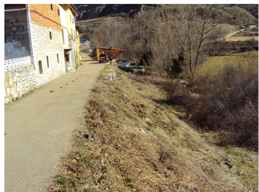
FOTO 6.- CALDAS. ZONA DE MURO
